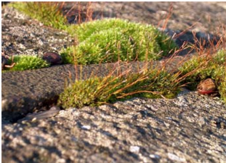
Bryophytes sur un parapet de pont en pierre calcaire
