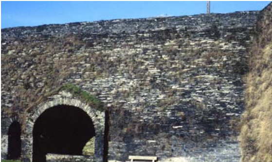
Lavoir sous l'ardoisière de Warmifontaine
