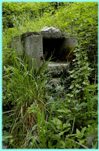
Sortie du caniveau qui passe sous la voie S.N.C.B. à Gendron-Celles, juste avant le tunnel.
