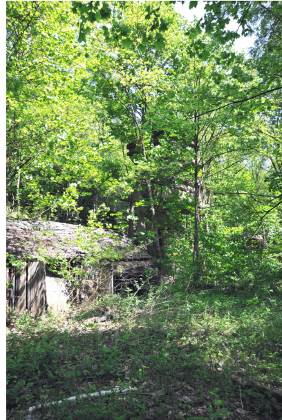
Ancien bâtiment d'exploitation
